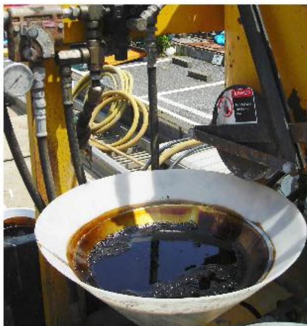
MEDの注入状況
