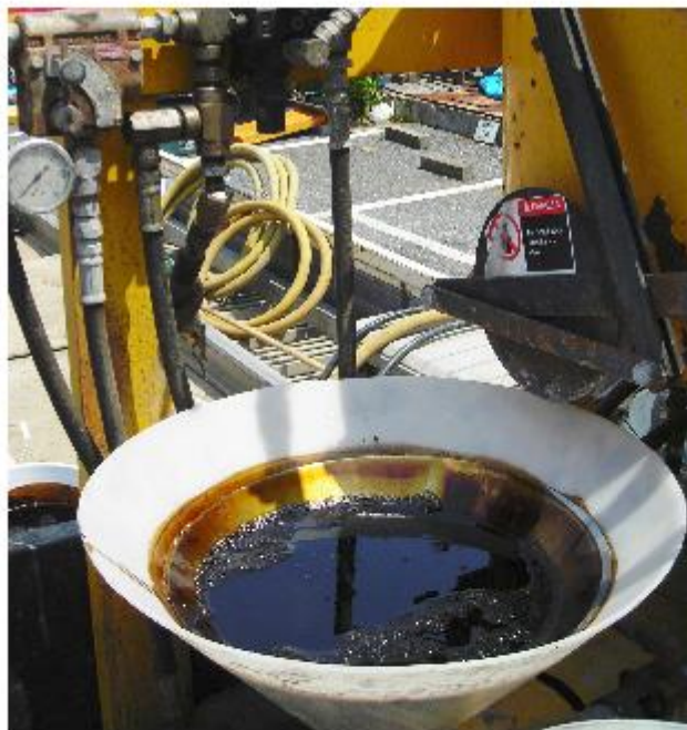
MEDの注入状況
